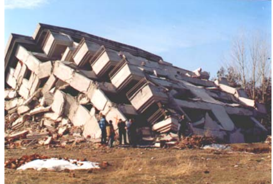
Çay / Deprem yüklerine karşı kalitesiz kılıcına kolonların yıkılması
