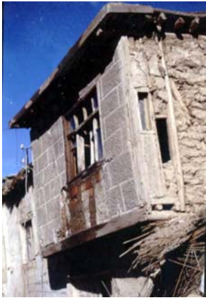
Sultandağı / Kerpiç bina, konsol cephe
