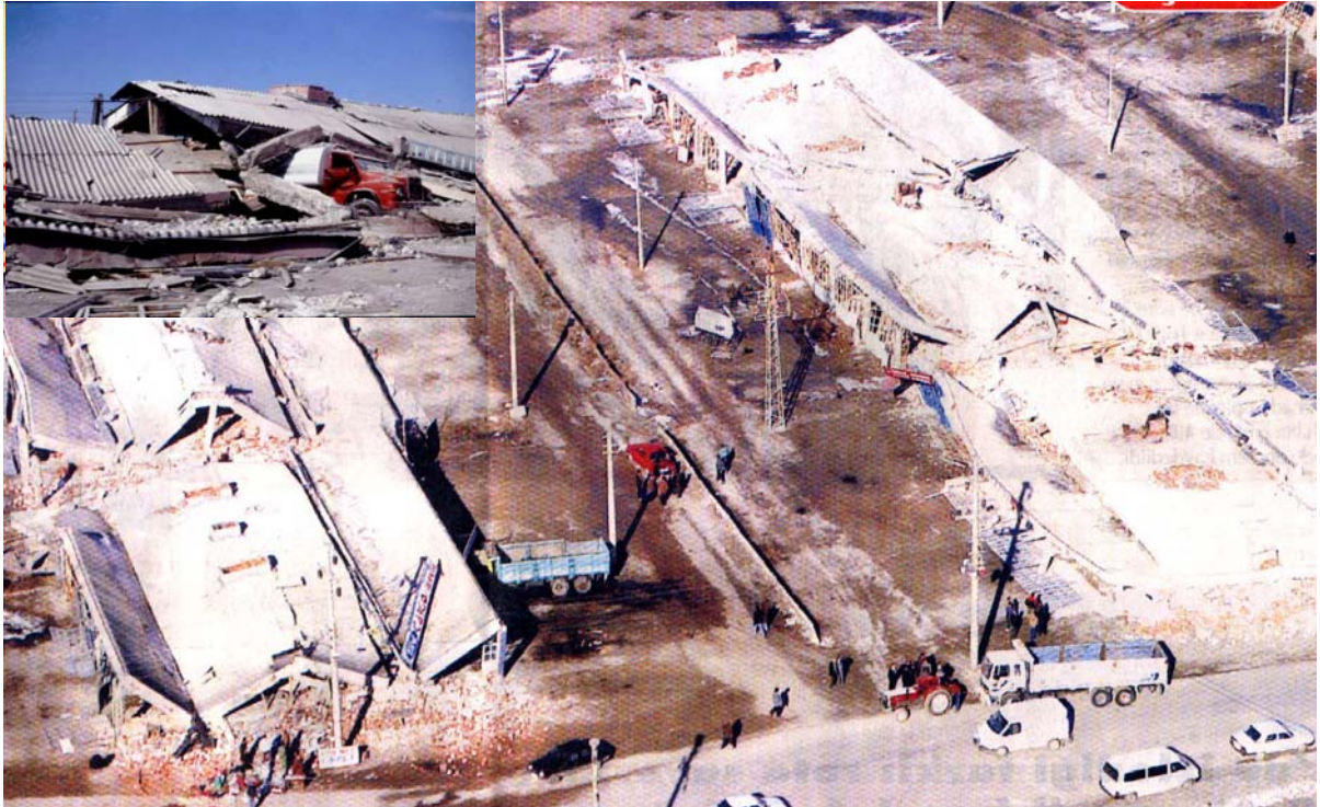
Çay Sanayi Sitesinde tümü ile çöken tek katlı B.A. iskelet yapılar
