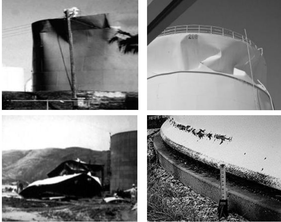
Şekil 4. Rüzgar ve sismik yüklerin silolarda neden olduğu burkulmalar
