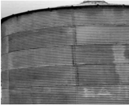
Şekil 8. Silolarda oluşan paslanma ve aşınma durumları
