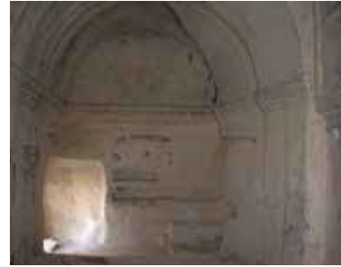
Resim 10: Kaya Kilise Naos, batı bölümü
