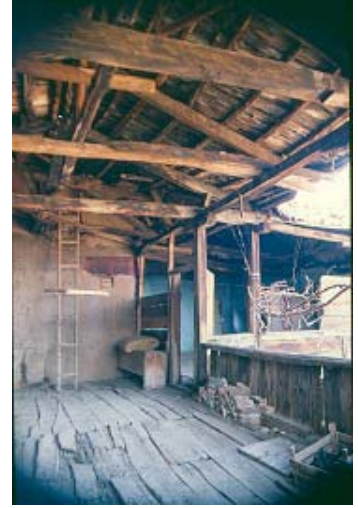
Resim 8: Elemanlardaki Bozulmalar
