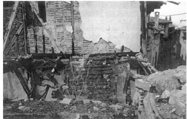
Resim 16: Baca Tutuşmasından Çıkan Yangında Çevresindeki İki Ev ile Yanmış Kalıntılar
