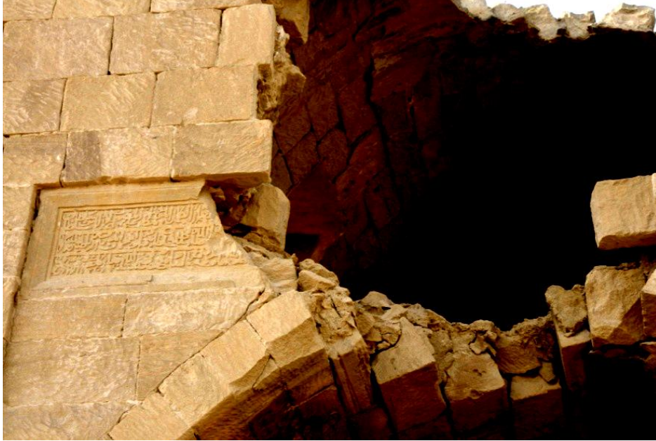
Foto 12: Karaçi Kervansarayı'nın giriş kapısı üzerindeki Arap harfli yazıtın görüntüsü
