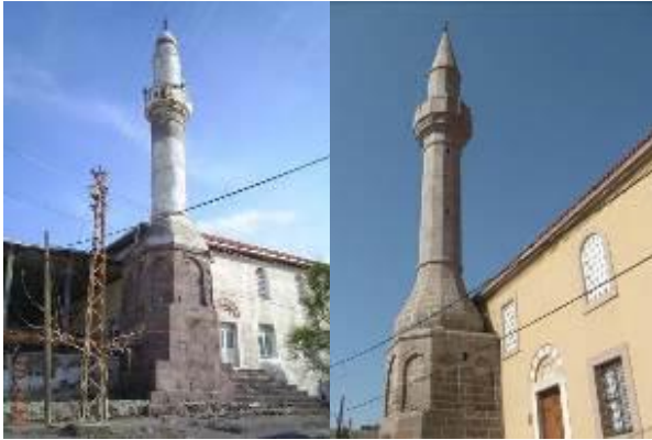
Res.13. Minare (restorasyon öncesi)
