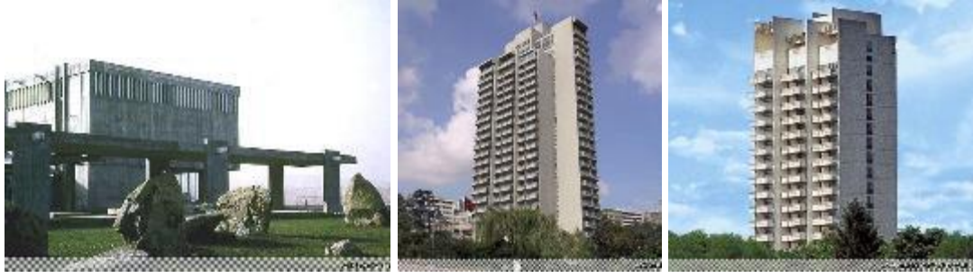
Şekil 4.a) ODTÜ Mimarlık Fakültesi, Ankara; b) Harbiye Orduevi, İstanbul; c) Ankara Stad Otel (www.arkiv.com.tr, Şubat 2012)
