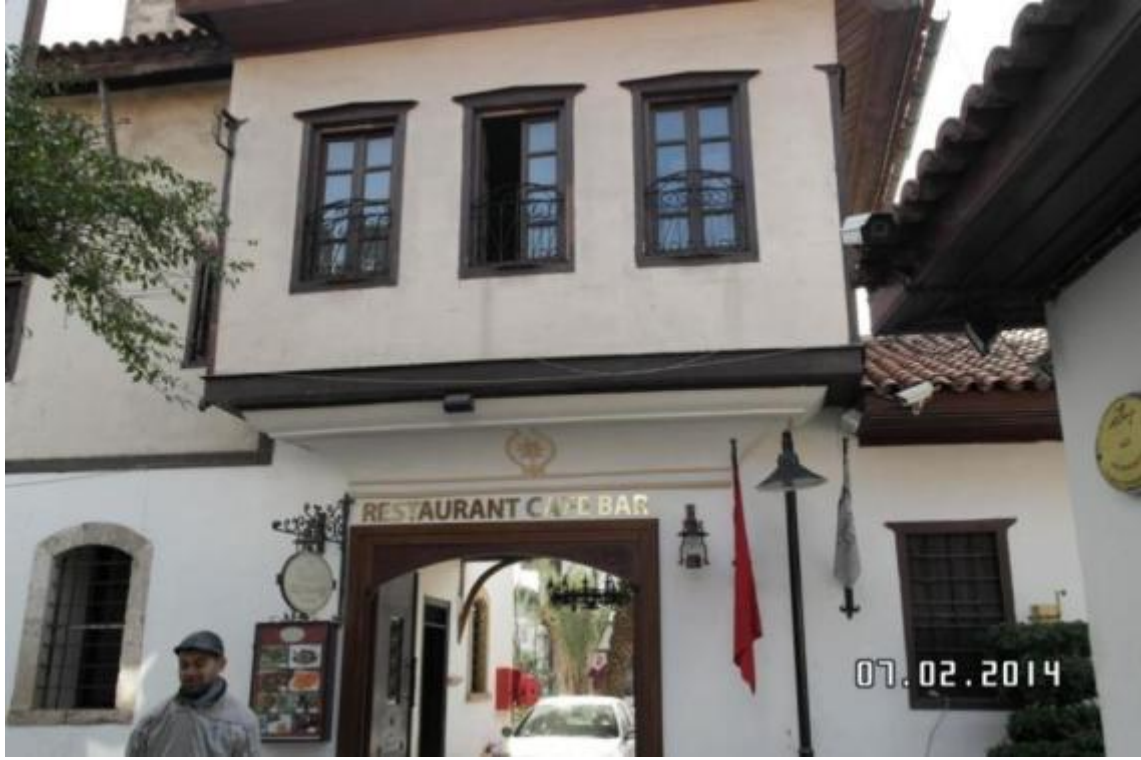
Resim 8: Hanımağa Konağı, Kuzey Cephe, Giriş, Cumba
