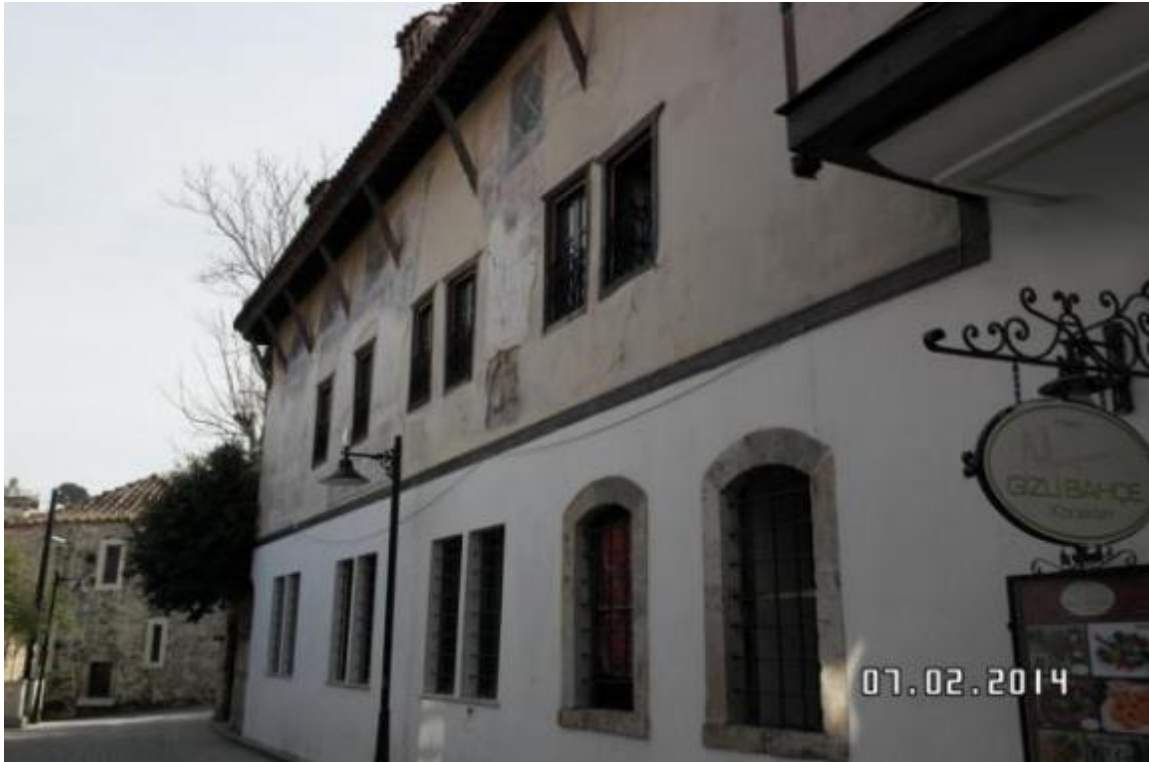
Resim 9: Hanımağa Konağı, Kuzey Cephe, Pencere Sistemi
