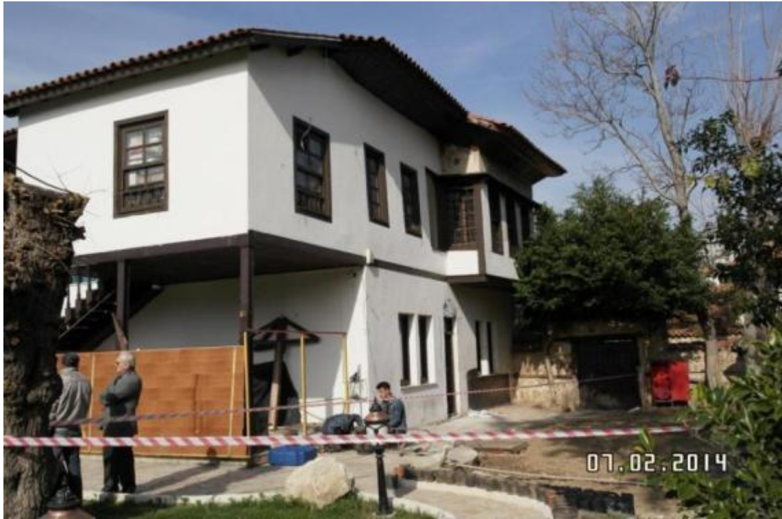
Resim 13: Hanımağa Konağı, Doğu Cephe ve Cumba
