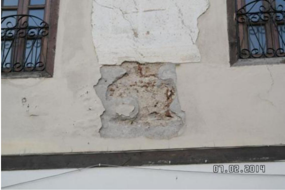
Resim 10: Hanımağa Konağı, Kuzey Cephe, Duvar, Malzeme
