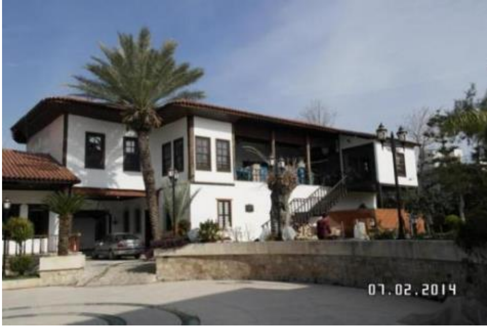
Resim 2: Hanımağa Konağı, Güney Cephe
