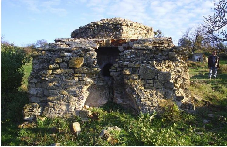
Res.19. Burhanlı Hamamı, ocak cephesi
