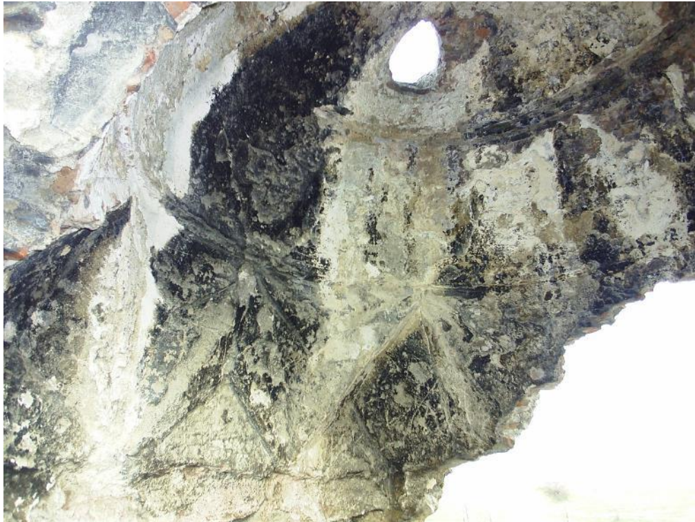
Res.41. Özbek Köyü Hamamı, sıcaklıkta kubbeye geçiş düzeni
