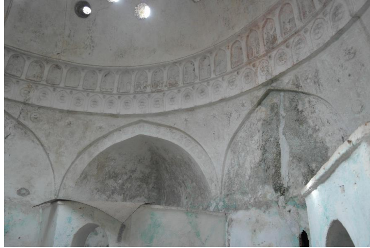
Res.6. Bayramiç Çarşı Hamamı erkekler kısmı, tromp ve kubbe
