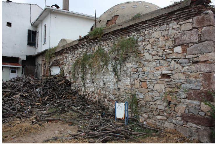
Res.12. Geyikli Hamamı, batı cephe
