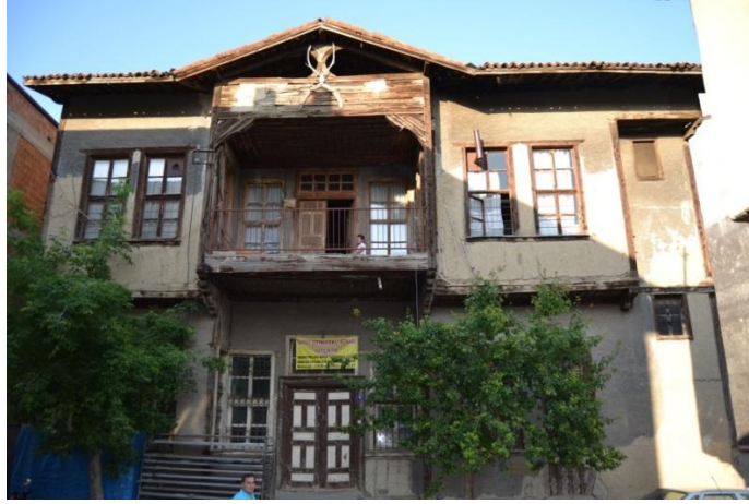
Foto.: 25 – Göynücekli Konağı Doğu Cephesi.
