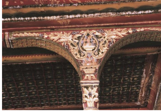
Foto.: 36 - Tokat Yađcıođlu Konađı Ahşap Taşıyıcı.
