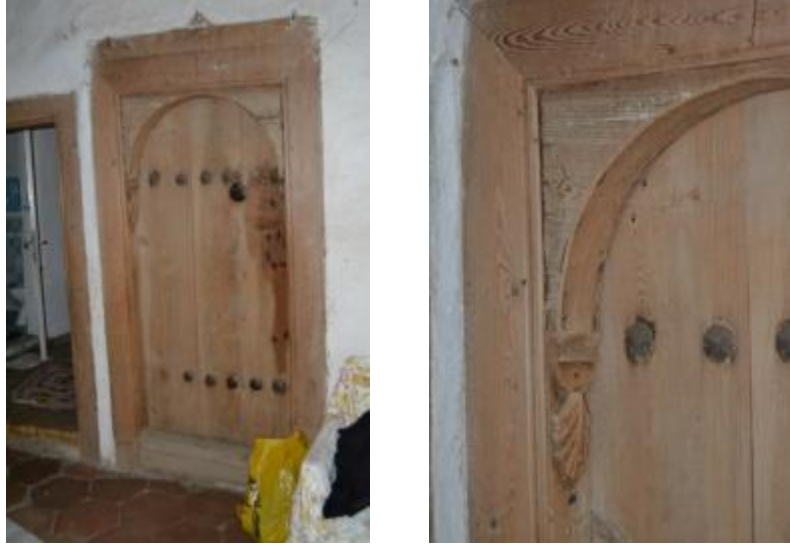
Foto.: 10-11 - Müftüoğlu Konağı Ahşap Kapı ve Ayrıntısı.
