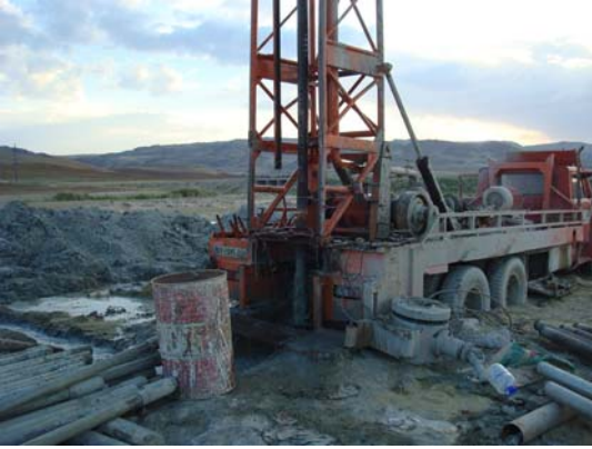
Resim 14. Fışkırmaya bağlı tekerlere kadar kum dolmuştur. Picture 14. Sand is fill till the wheel due to gushing.
