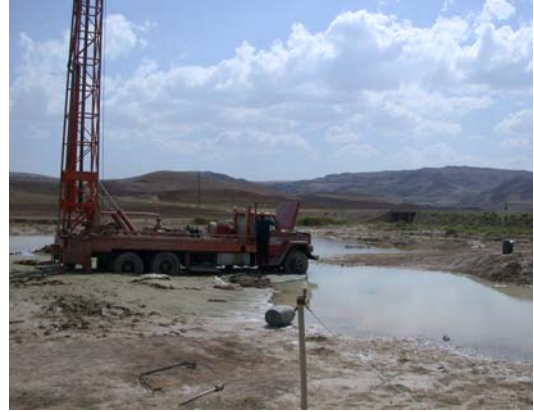
Resim 16. Fıskırmaya bağlı kum ve su çıkışı, şantiyenin durumu.
