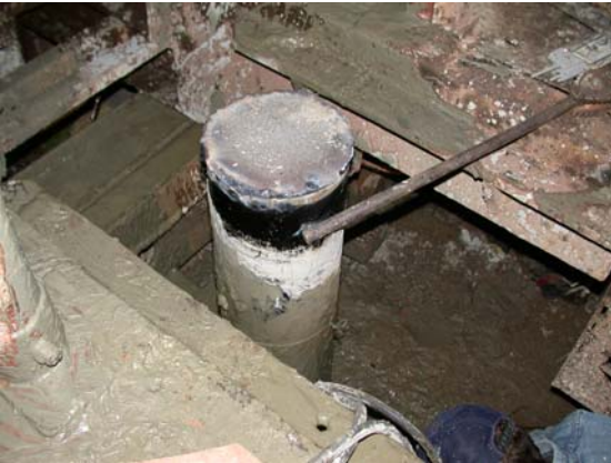
Resim 9. Tecrit borusunun kapatılması.
