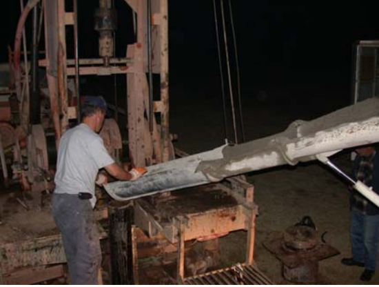
Resim 8. Tecrit için çimento dökümü.
