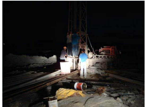
Resim 20. Çakarak tecrit borusunun çıkarılması. Picture 20. Pulling the isolation pipe by piling.
