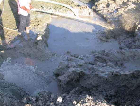
Resim 18. Yoğun çamur yapılıması. Picture 18. Preparation of dense mud.
