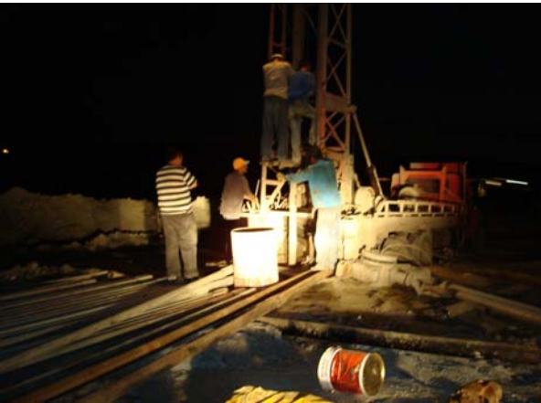
Resim 19. Rayba işleminin yapılması. Picture 19. Application of reaming process.
