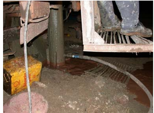
Resim 11. Çamur havuzu ve deplasman sıvısı seviyesinin ayarlanması.
