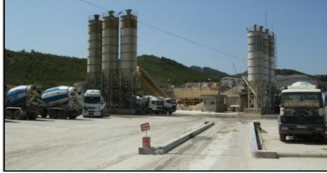
Fotoğraf 4. Çimsa Çimento San. ve Tic. A.Ş. Osmaneli Hazır Beton Tesisi.
