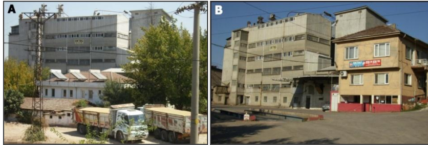
Fotoğraf 5. A-B. Ektaş Tarım Ürünleri End. ve Tic A.Ş. Osmaneli Un ve Yem fabrikasından görüntüler.
