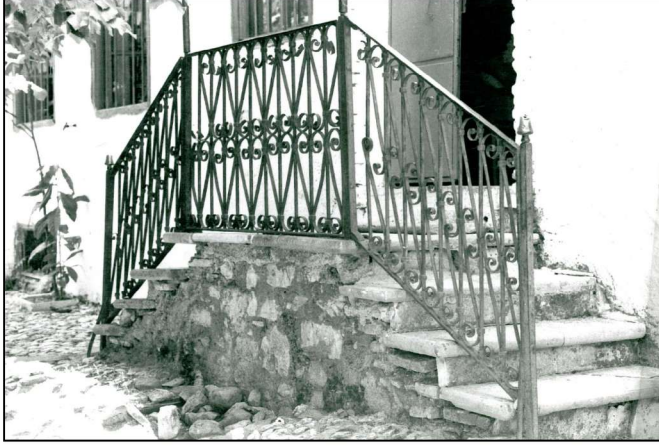
Resim 18: Matbah-ı řerîfın demir dövme merdiveni.
