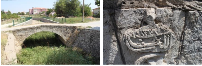
Fotoğraf 10-11. Muharremşah Köprüsü (Foto: T. Acar).
