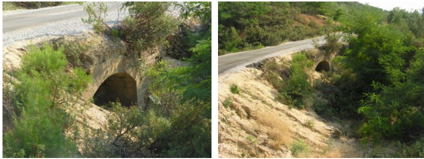
Fotoğraf 4-5. Gökçedal-Sarıdere Yolu Üzerindeki Köprü (Foto: T. Acar).
