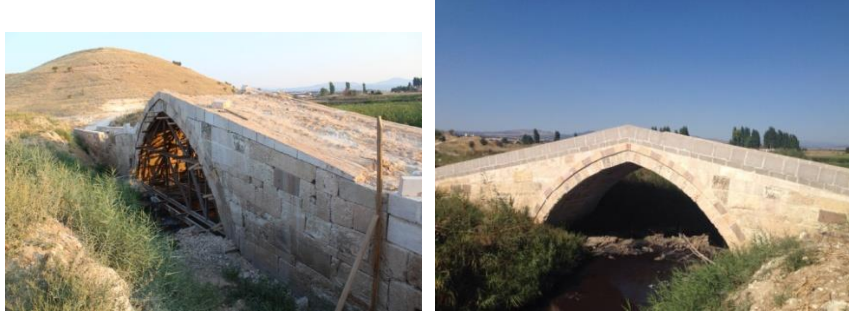
Fotoğraf 14-15. Onarım aşaması ve sonrası Çanlı Köprü (Foto: T. Acar).
