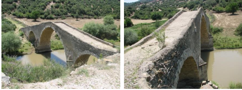
Fotoğraf 25-26. Çataltepe Köprüsü (Foto: T. Acar).
