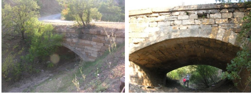
Fotoğraf 6-7. Aşağı Karabeyli Mahallesi Yakınlarındaki Köprü (Foto: T. Acar).
