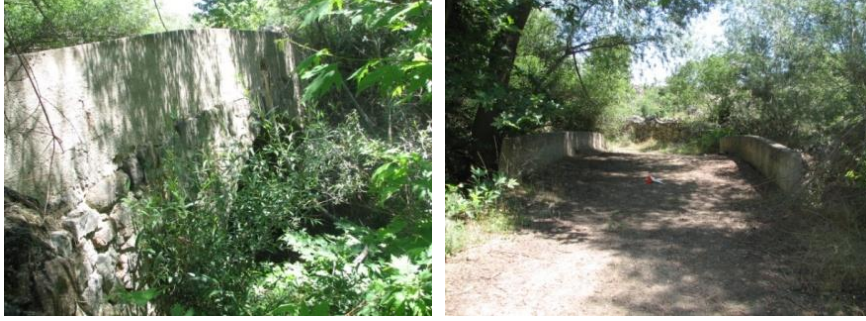
Fotoğraf 35-36. Büyükköy Köprüsü (Foto: T. Acar).
