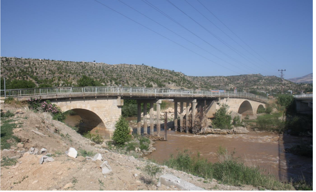
Fotoğraf-5. Göksu ( Kadı) Köprüsü genel görünüm.
