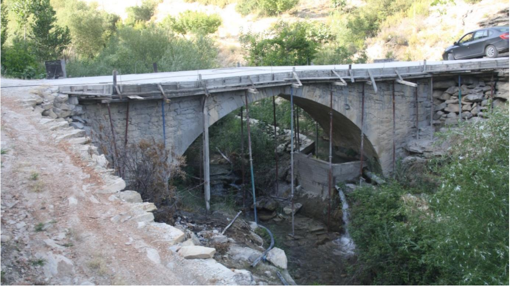
Fotoğraf-3. Eşekçi Köprüsü genel görünüm.
