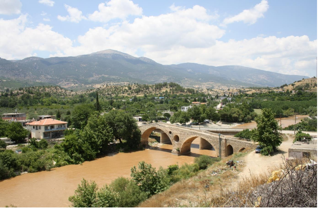
Fotoğraf-9. Kravga Köprüsü genel görünüm.
