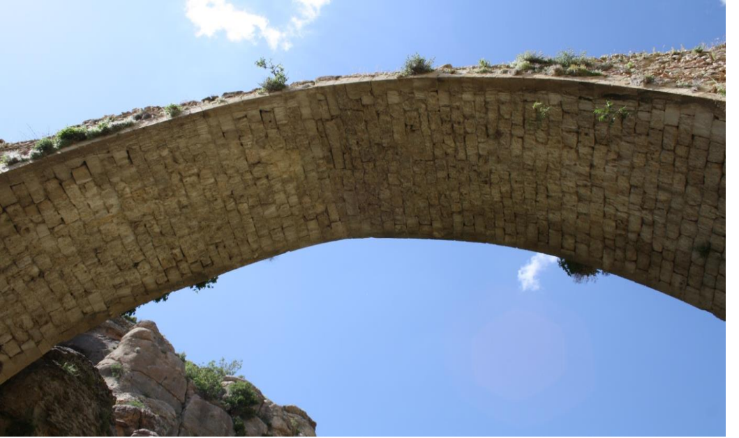
Fotoğraf-8. Keben Köprüsü sivri kemer ayrıntı.
