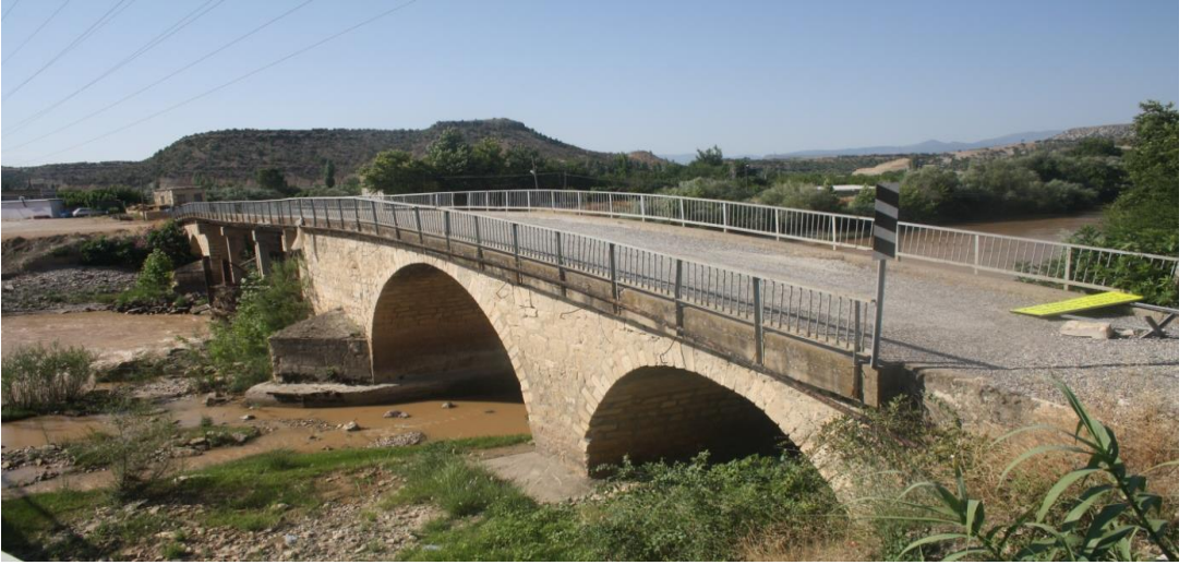
Fotoğraf-6. Göksu ( Kadı) Köprüsü menbağ yönü.
