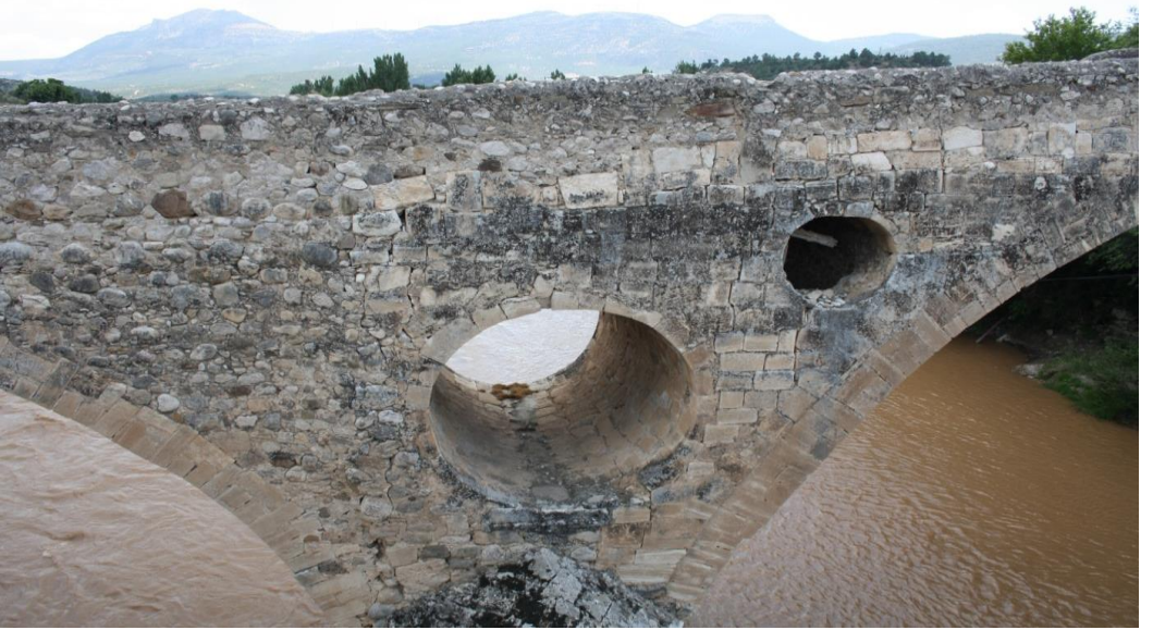
Fotoğraf-10. Kravga Köprüsü boşaltma gözleri.
