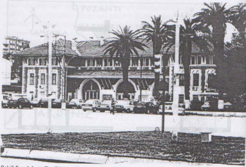
Şekil 5: Adana Gar Binası, Meydan Cephesi
