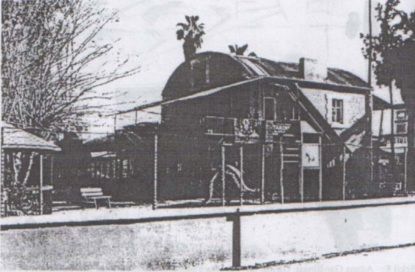
Şekil 10: Adana Eski İstasyon Binasi, Genel Görünüş
