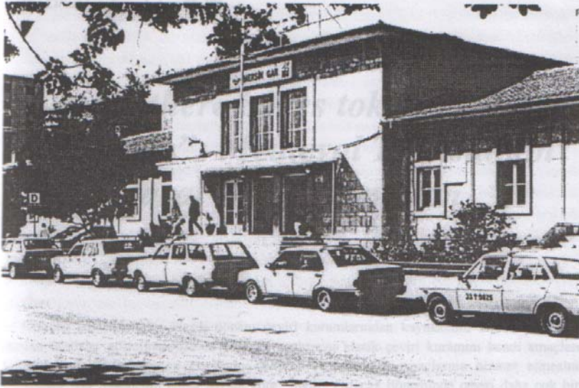
Şekil 15: Mersin İstasyon Binası, Genel Görünüş
