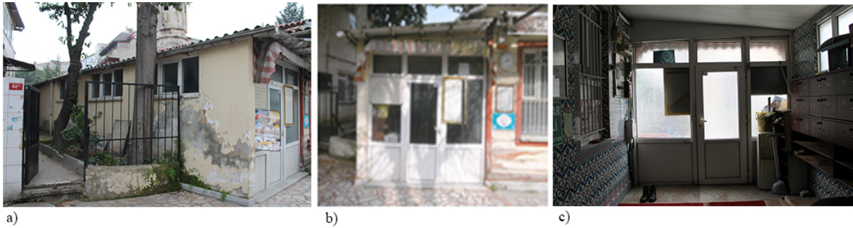
Şekil 10. Ek kısım; a) kuzey cephesi, b) batı cephesi, c) iç mekân, batı cephesi, 2018
