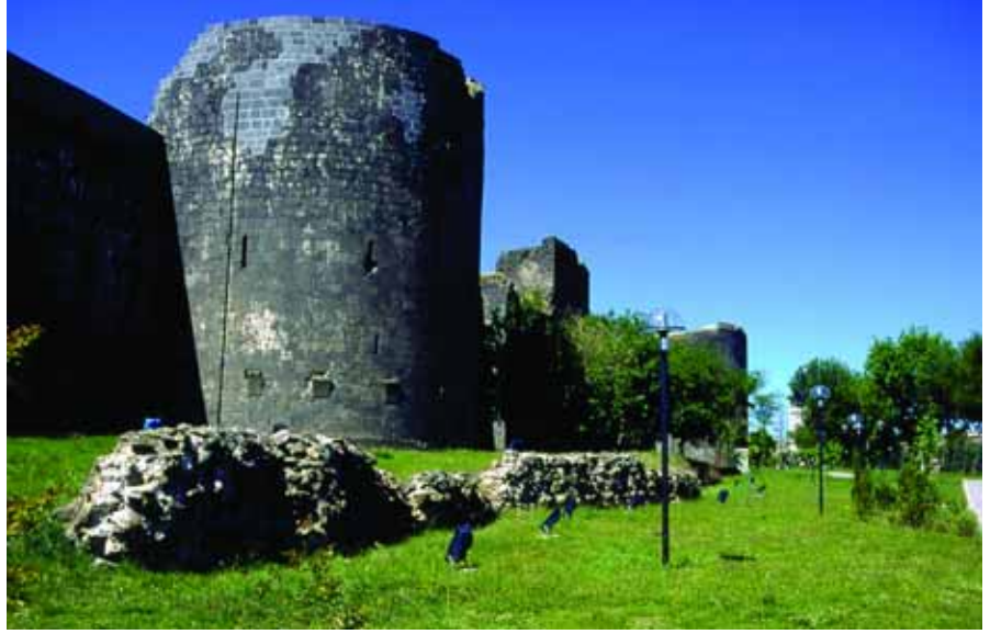
Resim 1. İç Kale'nin kuzeydoğusundaki dış surlara ait kalıntılar (C. Parla, 2004).
