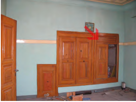
Resim 11. Hanoğulları Konağı'nda her iki odadan kullanılan gusülhane (Röhlöve ve foto: Ö.İ. Tuluk).
