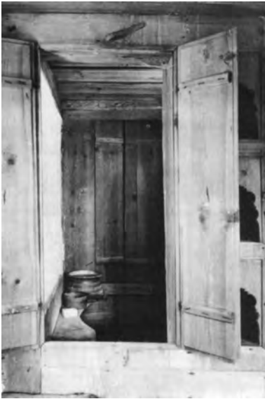
Resim 11. Hanoğulları Konağı'nda her iki odadan kullanılan gusülhane (Röhlöve ve foto: Ö.İ. Tuluk).
