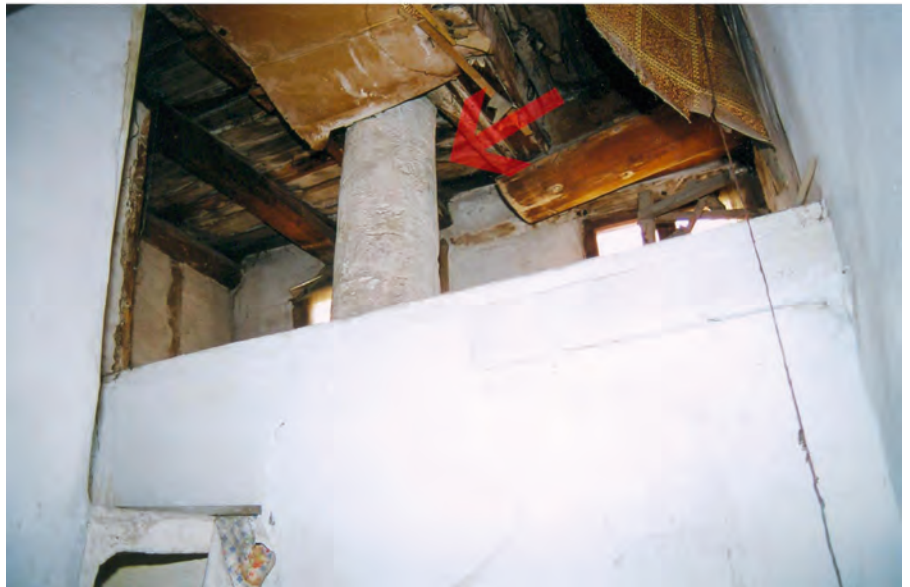
Resim 24. Şeyh Hacı Faik Efendi Evi kuzey-batı köşedeki odaya bitişik küçük odadaki ocaklık, ateş haznesi ve baca (Ö.İ. Tuluk arşivi).
