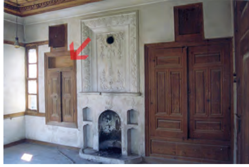
Resim 9. Kavukçular Konağı'nda gusülhane (Rölöve ve foto: Ö.İ. Tuluk).
