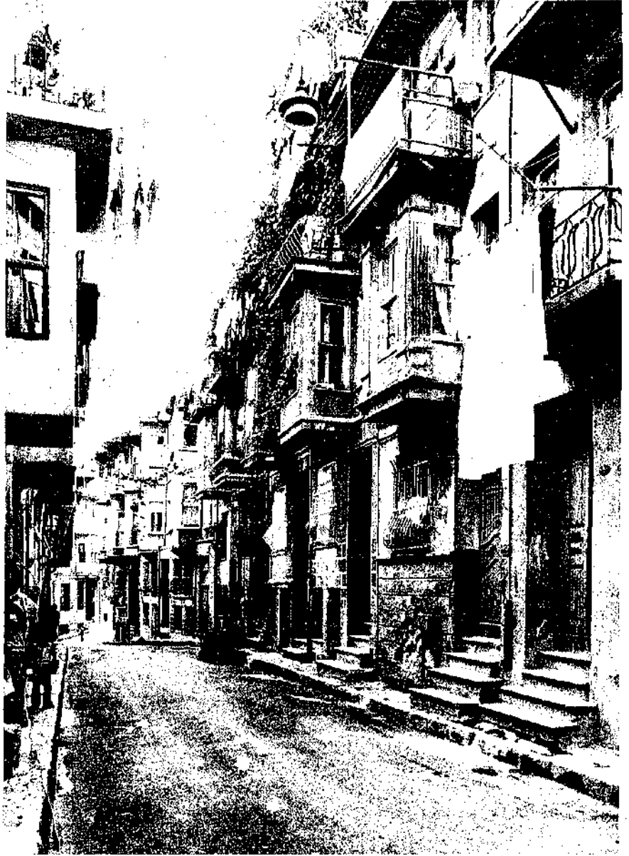
Şekil 10. Fener, Fener Külhanı Sokağı: 7, 9, 11 no.lu evler
