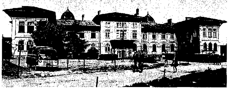
Resim 37. İstanbul-Yeni Guraba Hastahanesi, yönetim merkezi ve poliklinik binası, güney-batı'dan görünüş.
