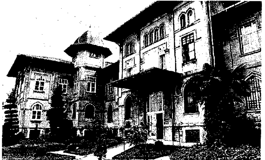
Resim 40. İstanbul-Yeni Guraba Hastahanesi, yönetim merkezi ve poliklinik binası, kuzey-doğu'dan görünüşü.
