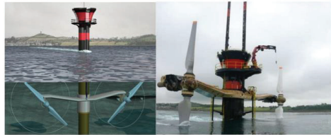
Şekil 3. Siemens'e ait yatay eksenli 20 m çapa, 2 kanata ve 2000 kW güce sahip akıntı türbini [3]
