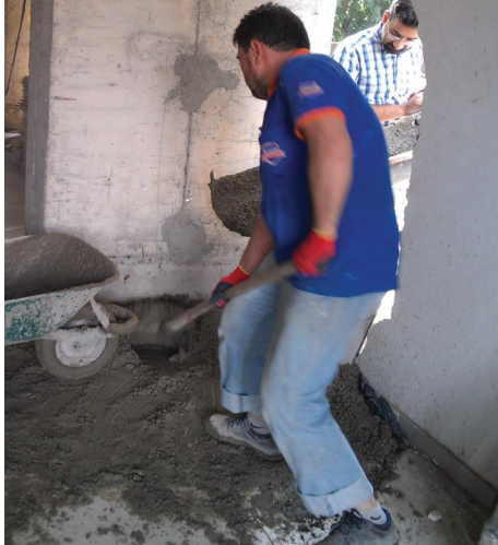
Şekil 1. Beton dökümü
