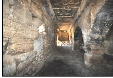
Resim 2. Ağızhan Köyü Taş Yapısı İçten Görünüm.
