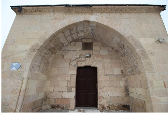
Fotoğraf 14. Kuzey cephe, eyvan şeklinde giriş bölümü
