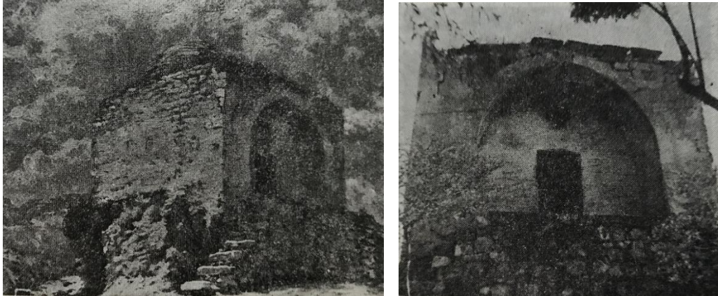
Fotoğraf 2 ve 3 Onarımlardan önce Giriş cephesi ve merdivenler (Altun, 1981-82)
