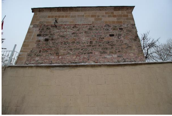
Fotoğraf 12. Batı Cephe
