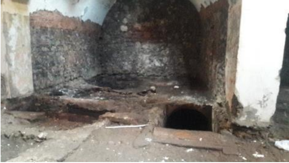
Resim 15. İkinci avluda merdivenle inilen depo bölümü
