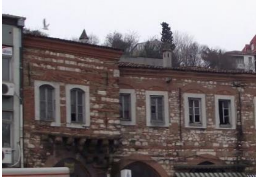
Resim 3. Ali Paşa Hanı'nın bir sıra taş- iki sıra tuğla duvar örgüsü – 18. Yüzyıl
