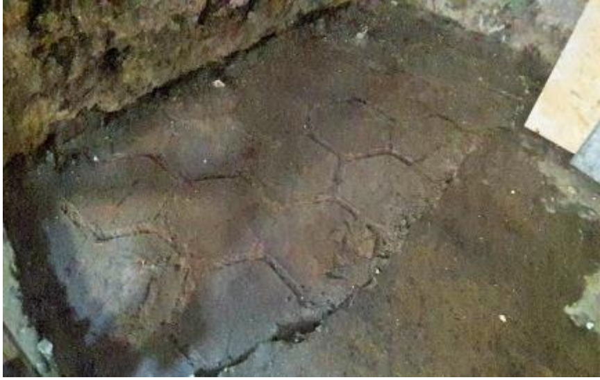
Resim 12. Oda zeminindeki şeshane tuğlaları
