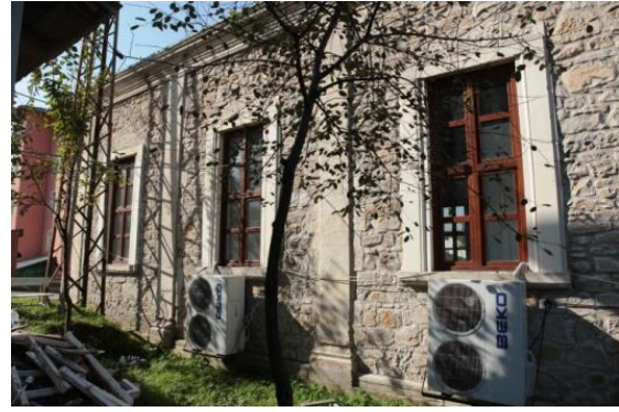
Foto.8. Bolaman Yenipazar Camii doğu cephe.
