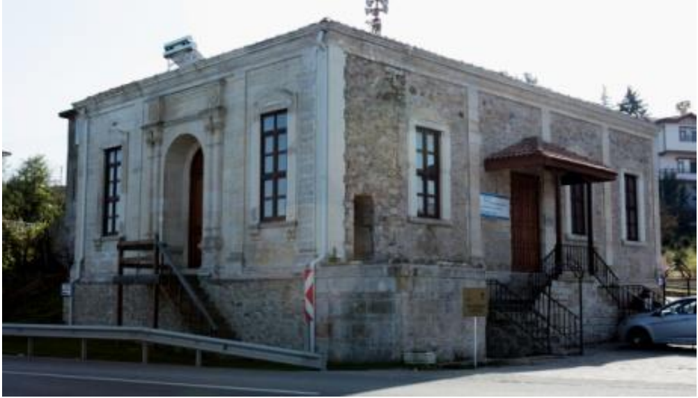
Foto.2. Bolaman Yenipazar Camii kuzey ve batı cepheler.
