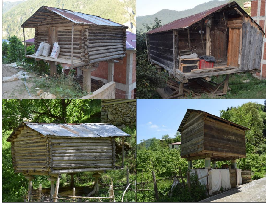
Fotoğraf 12. Tabiat Parkının yakın çevresinde, kütük ve ahşap yığma tekniğiyle yapılmış serentilerden görünümler.
