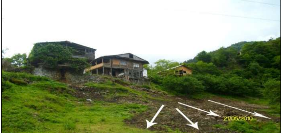
Foto 1. Camili köyünde evleri tehdit eden heyelandan bir görünüm (Çağlar Kıvanç KAYMAZ arşivinden)
