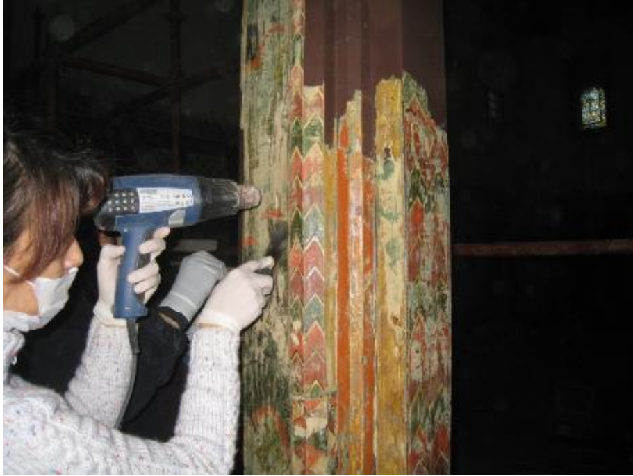
Foto 15. Hacı Bayram Camisi, Kadınlar Mahfili Direklerindeki Yağlı Boya Tabakalarının Kaldırılması Çalışmalarından (2011 Yılı Onarımı)
