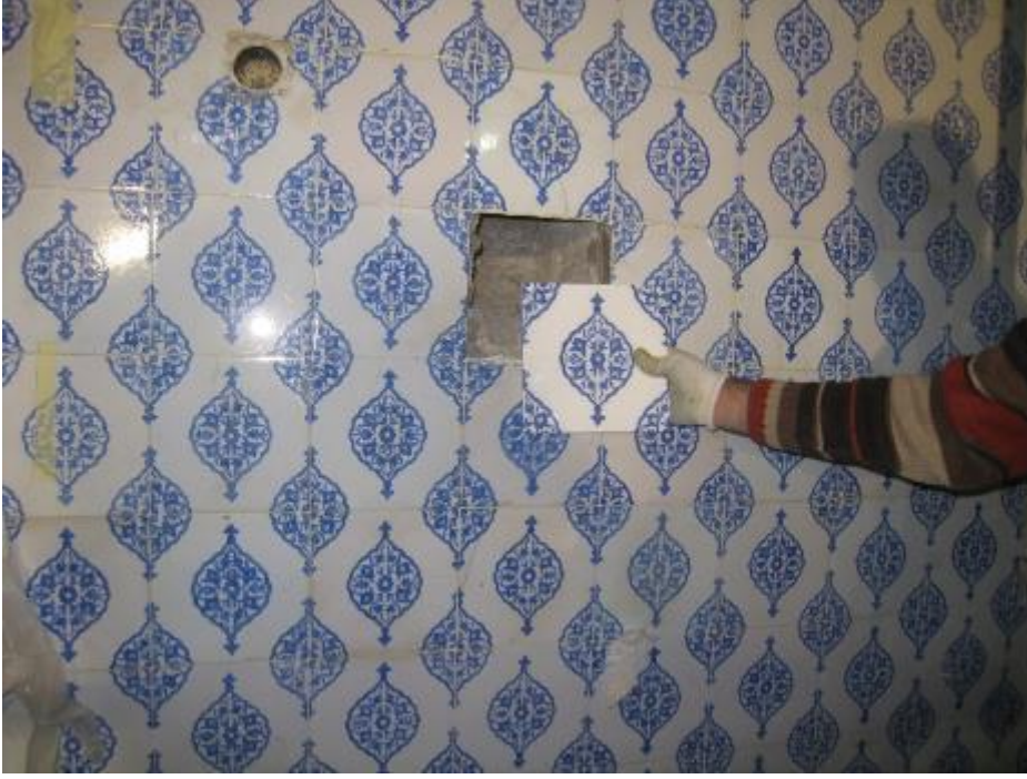
Foto 20. Hacı Bayram Camisi, Harimdeki Duvar Çinilerinin Onarımı Çalışmalarından (2011 Yılı Onarımı)
