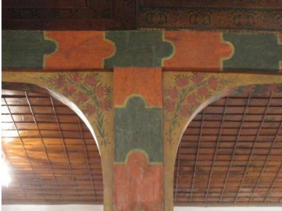
Foto 18. Hacı Bayram Camisi, Kadınlar Mahfili Ahşap Elemanlarındaki Yağlı Boya Tabakaları Kaldırıldıktan Sonra Ortaya Çıkarılan Boyalı Süslemelerden Detay (2011 Yılı Onarımı)
