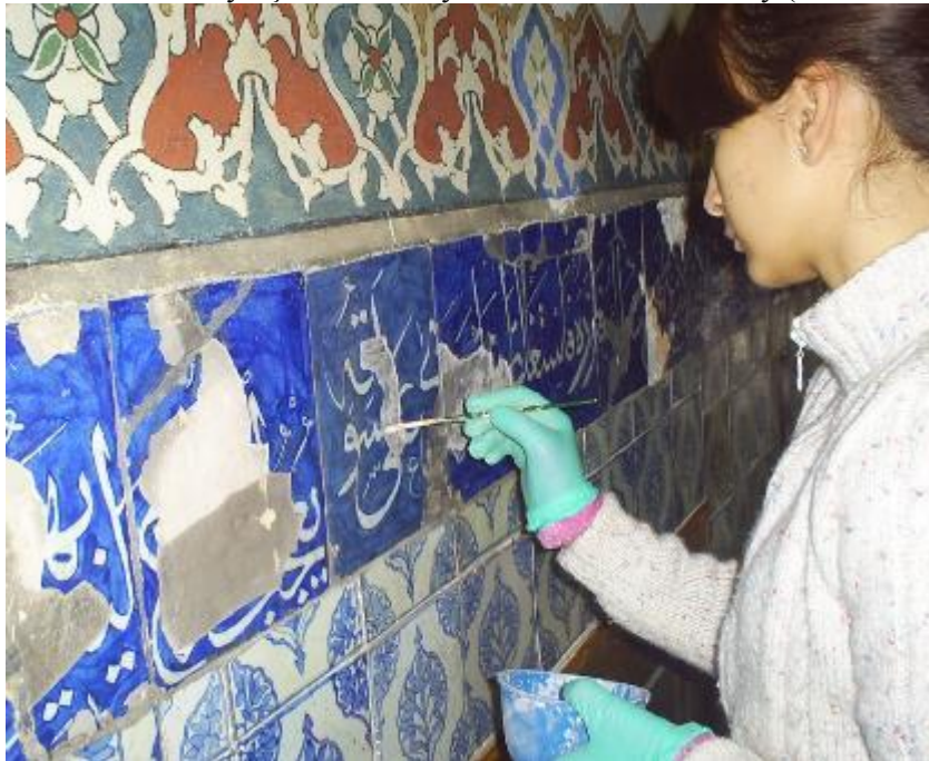
Foto 19. Hacı Bayram Camisi, Kadınlar Mahfili Altındaki Çinilerin Onarımı Çalışmalarından (2011 Yılı Onarımı)
