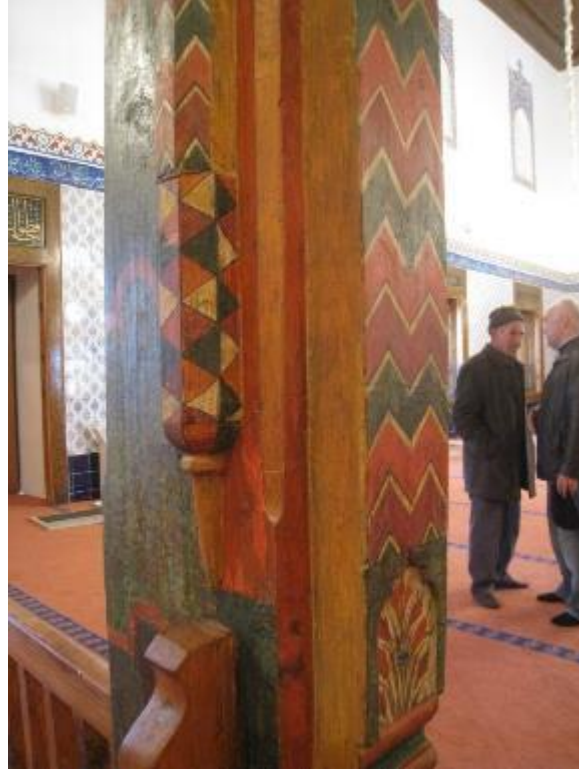
Foto 16. Hacı Bayram Camisi, Kadınlar Mahfili Direklerindeki Yağlı Boya Tabakaları Kaldırıldıktan Sonra Ortaya Çıkartılan Boyalı Süslemeler (2011 Yılı Onarımı)
