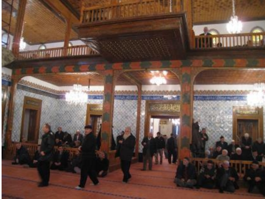
Foto 17. Hacı Bayram Camisi, Kadınlar Mahfili Ahşap Elemanlarındaki Yağlı Boya Tabakaları Kaldırıldıktan Sonra Ortaya Çıkartılan Boyalı Süslemeler (2011 Yılı Onarımı)
