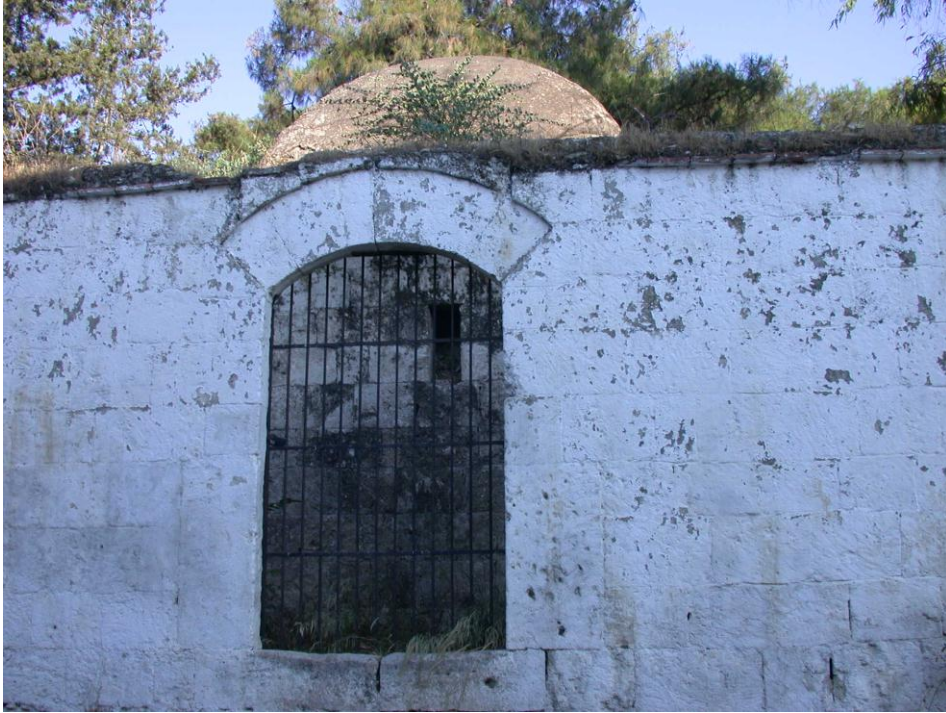
Fotoğraf 4- Tarsus Duatepe Türbesi, çevre duvarının batı cephesi üzerindeki giriş.
