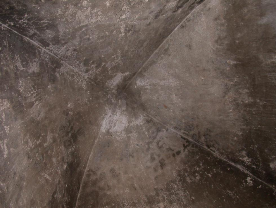
Fotoğraf 8- Tarsus Duatepe Türbesi, türbenin manastır tonoz örtüsü.
