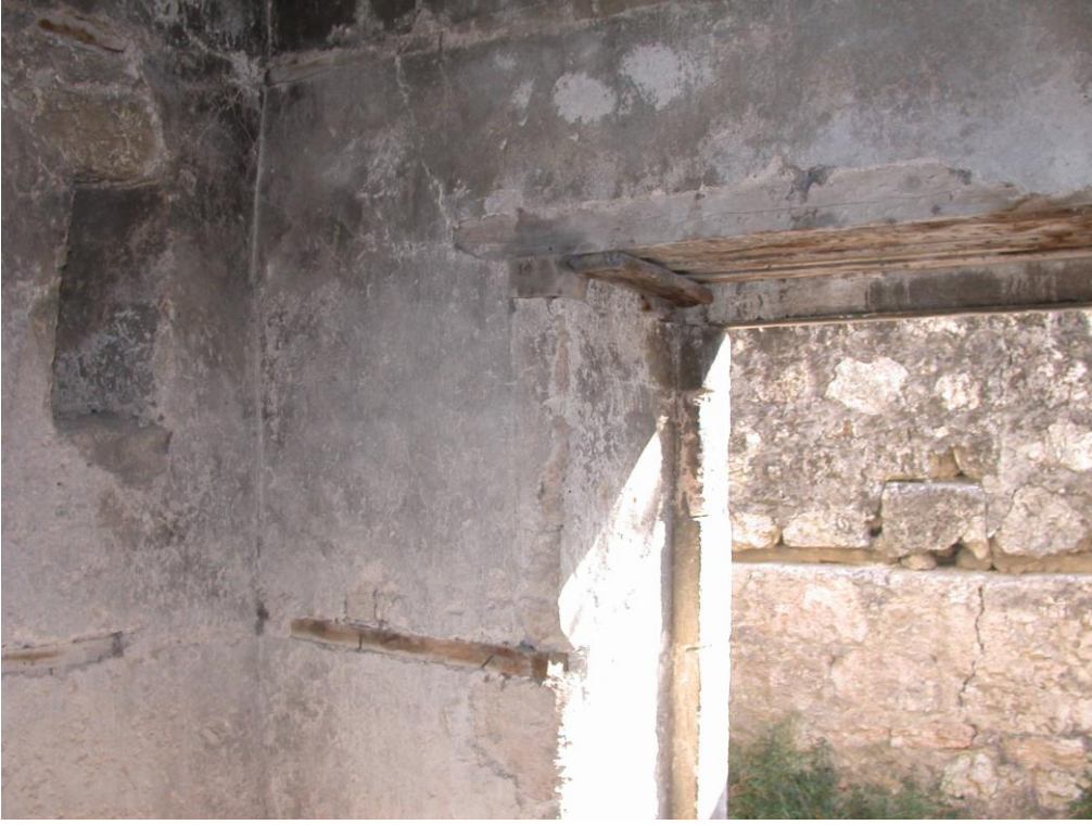
Fotoğraf 9- Tarsus Duatepe Türbesi, türbenin girişinin içten görünüşü ve doğu duvarı üzerindeki menfez şeklindeki havalandırma penceresi.
