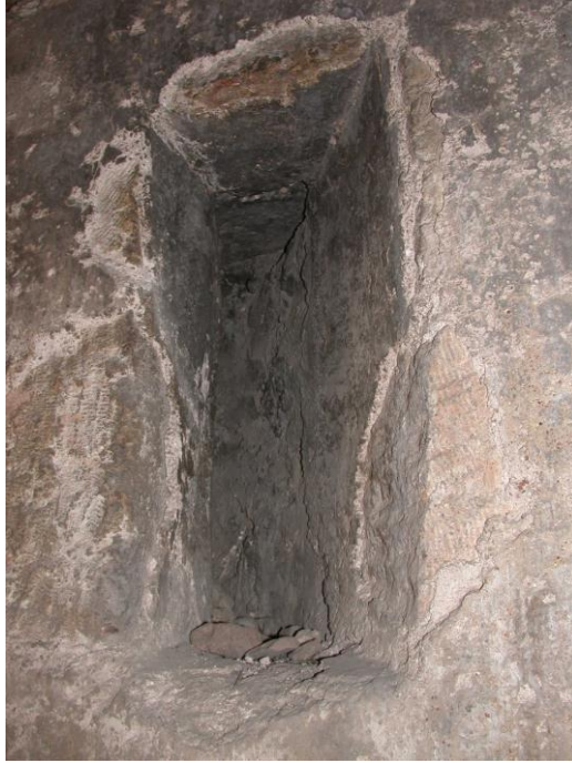
Fotoğraf 10- Tarsus Duatepe Türbesi, türbenin doğu duvarı üzerindeki menfez şeklindeki havalandırma penceresi.
