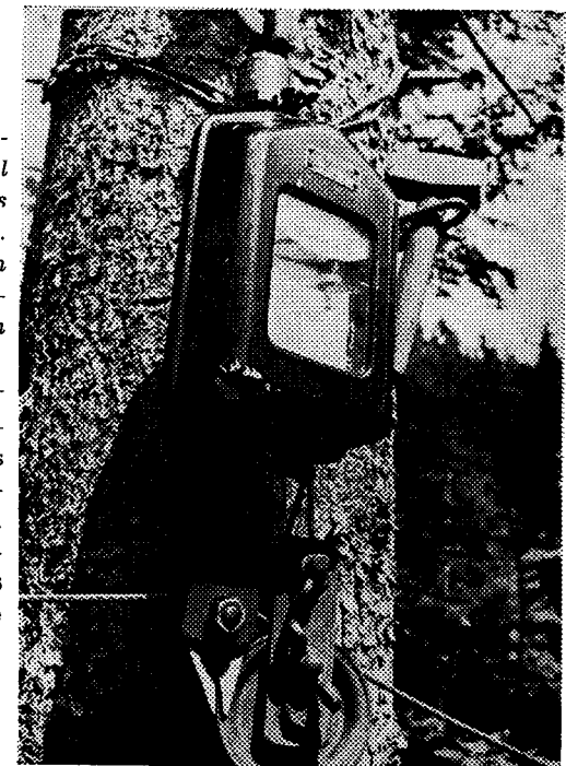
Abb. 4. Zur Erreichung genauer Werte der Spannungsveränderung im Seil muß das Probeseil wie später das Tragseil auf den Stützenrollen gleiten. Hierzu werden die Stützenrollen noch Anspannen des Probeseiles durch Einstecken von 16 mm Mutterschrauben «gesperrt» (Aufn. : P.)
