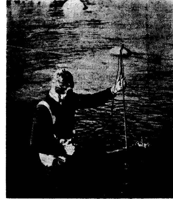
Şekil: 4. Hız Ölçmelerinde PRICE tipi bir mulinenin kullanışığı. (USDIBR, 1967 den alınmıştır.)
