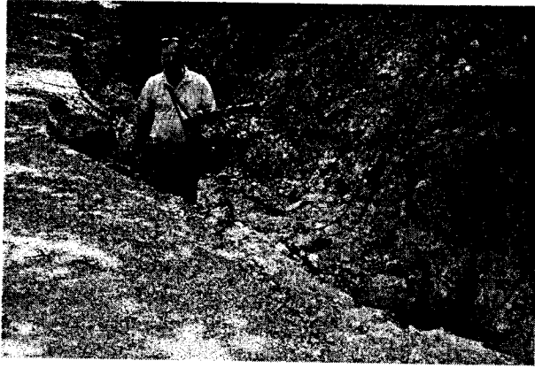
Figure 8. Deformation at ditches and lost of pavement materials (Photo: T.Oztürk) Şekil 8. Üstyapı materyalinin kaybı ve hendeklerdeki deformasyon
