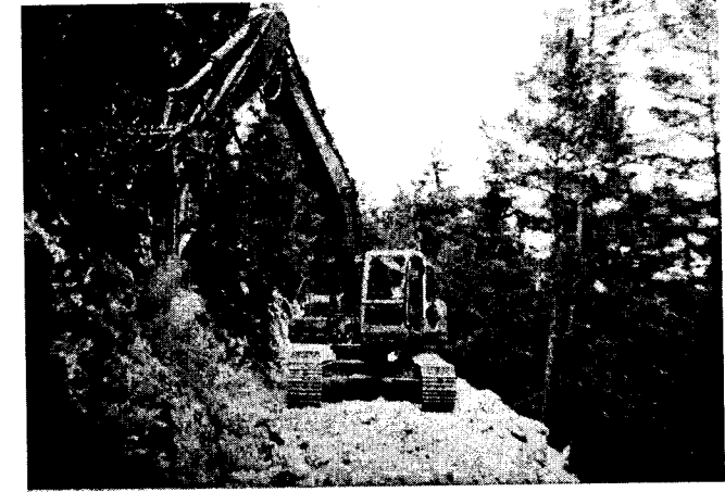
Figure 4. Constructing the subgrade by an excavator (Photo: T.Ozturk) Şekil 4. Bir ekskavator ile yol temelini yapılması
