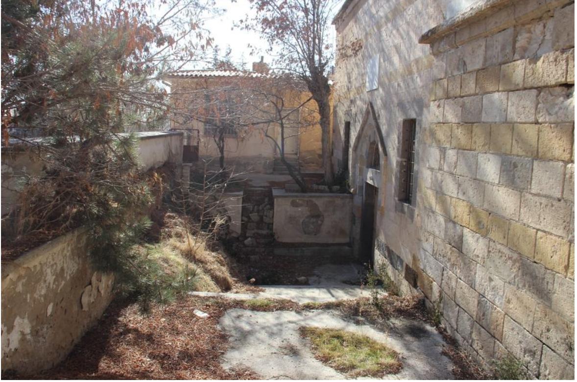
Fotoğraf 1: Fertek Köyü Hamamı doğu cepheden görünüm.
