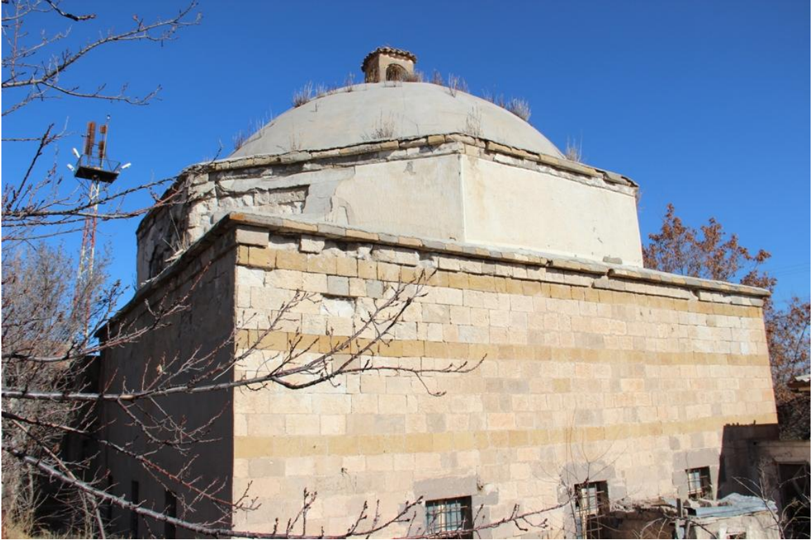
Fotoğraf 2: FerteK Köyü Hamamı güney-batı taraftan soyunmalık cephesi.
