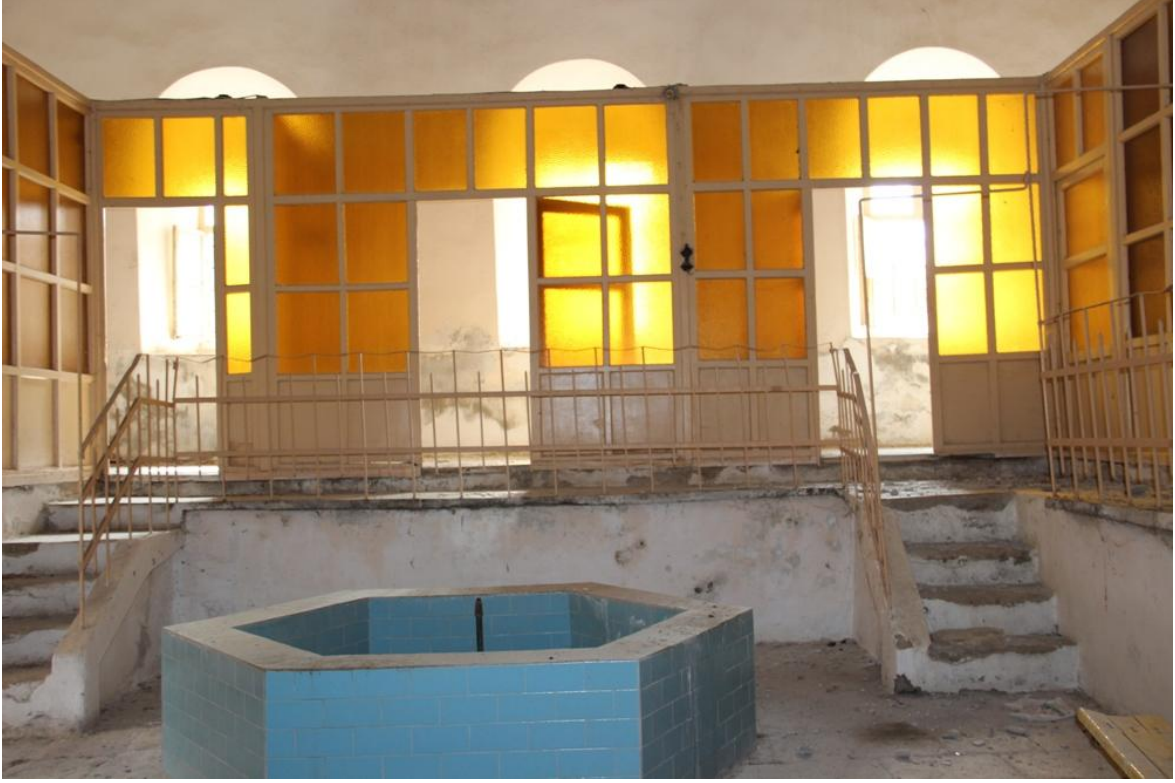
Fotoğraf 5: FerteK Köyü Hamamı soyunmalık kısmından bir görünüm.
