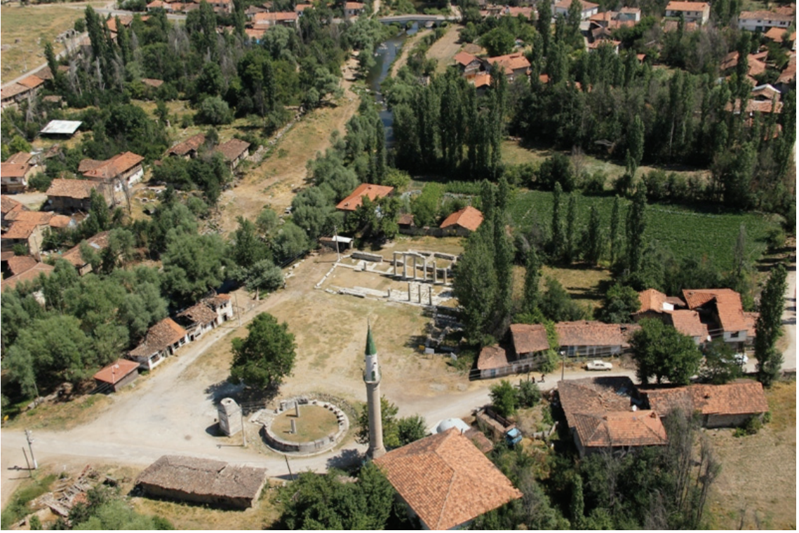
Resim 5. Aizanoi Macellum alanı ve yuvarlak yapı
