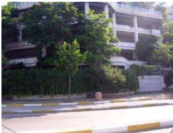
Foto 11 : Eski Kıyının Kanıtı Olan Kıyı Gerisindeki Yapılar
