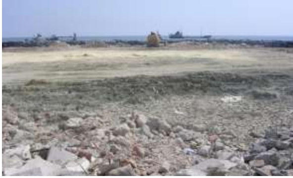
Foto 9 : Avcılar İlçesinde 2005 Yılında Yapılan Kıyı Dolgu Çalışmaları
