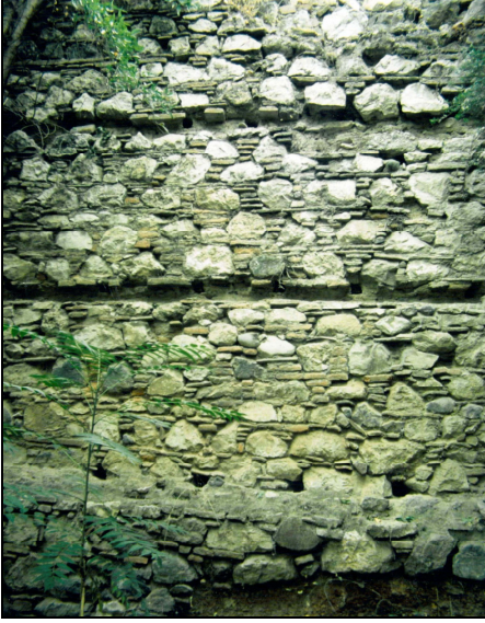
Resim 11: Semâhane beden duvarındaki hatıl ve kirişleme izleri.
