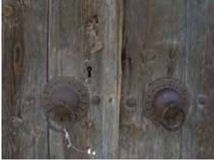
Resim 3. Şehir Bölgesi Ulukavak Sok. No. 8/A
