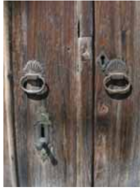
Resim 41. Şehir Bölgesi Ulukavak Sok. No. 16/A
