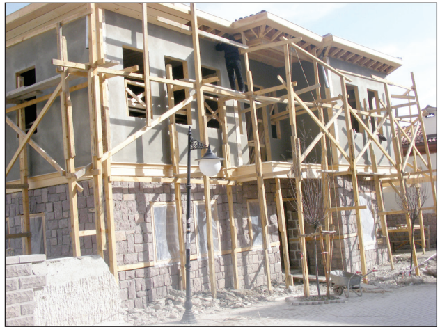
Şekil 7B. Hamamönü'nde yıkılanların yerine yapılmakta olan yeni bir yapı.
