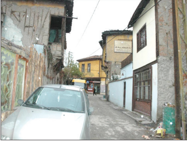
Şekil 5A. Dutlu Sokak'ın eski durumu.
