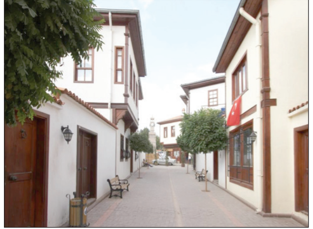
Şekil 5B. Dutlu Sokak'ın yeni durumu.
