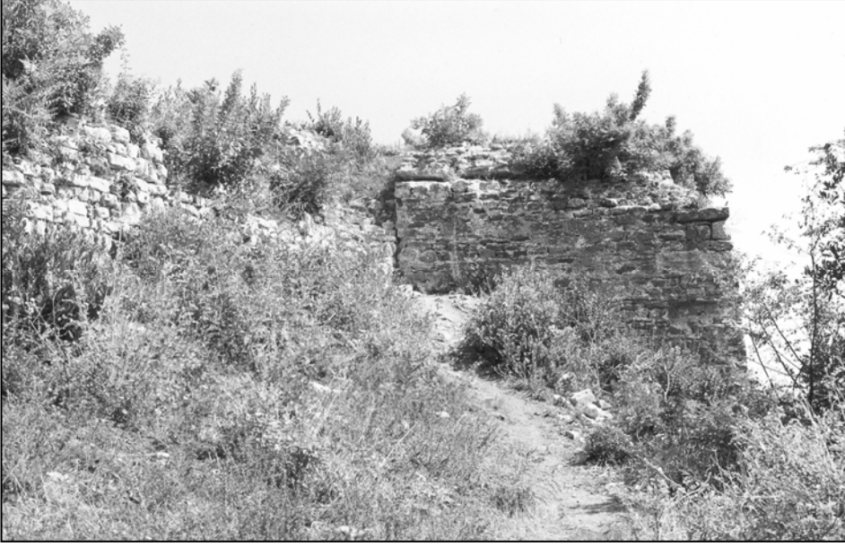
Resim 5. Güney Cephe, Doğu Burç, Doğuya Bakış.
