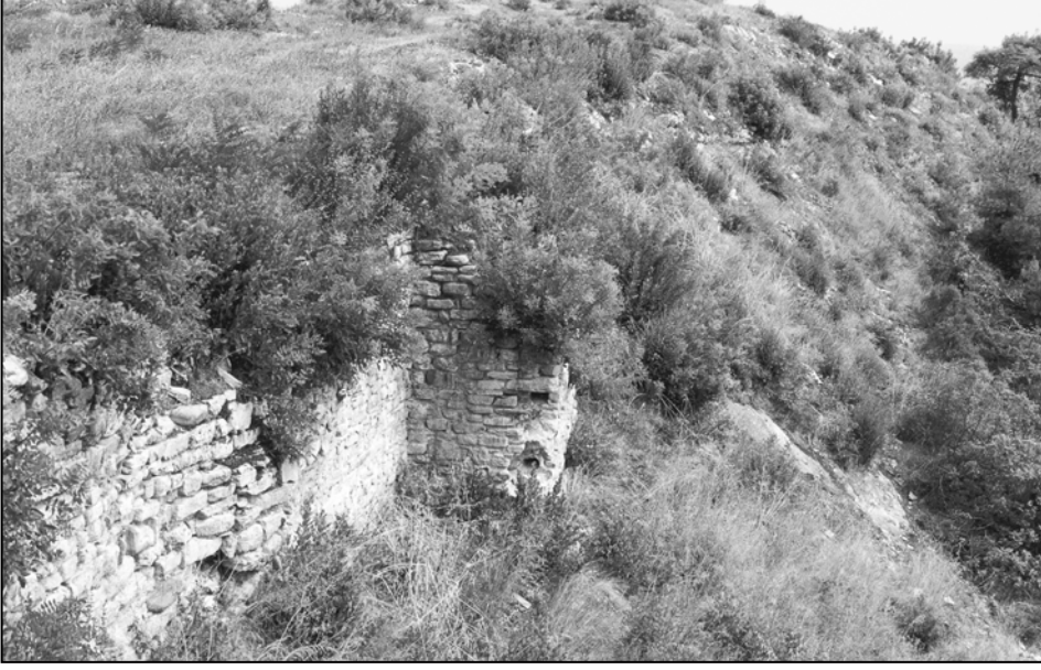
Resim 13. Sur, Güney Cephe, Doğuya Bakış.
