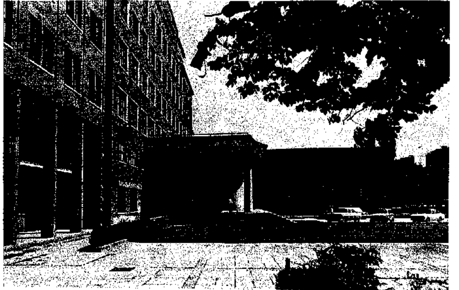
Şekil 10. Dil ve Tarih-Coğrafya Fakülte Binası, Giriş.
