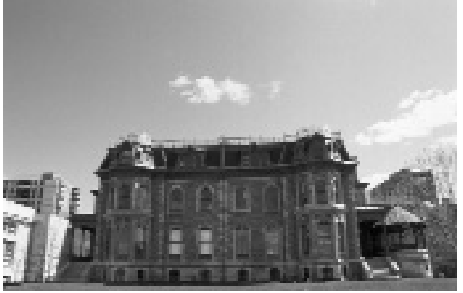
Resim 1. Shaughnessy Evi (A.U. Peker, 2000).
