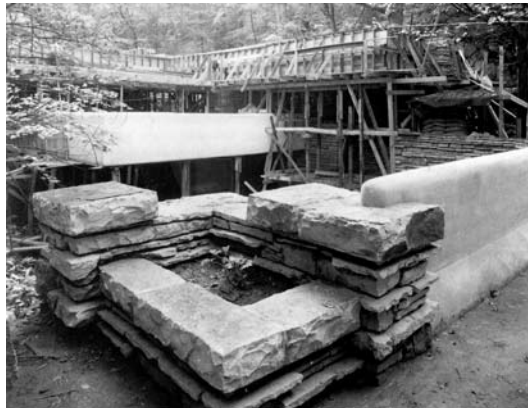
Resim 10. Frank Lloyd Wright, Fallingwater Evi. Köprü ayaklarının yeniden inşa edilmiş hali. Fotoğraf: Donald Hoffmann. Hoffmann (1993), 27 numaralı görsel. Eser sahibinin izniyle.
