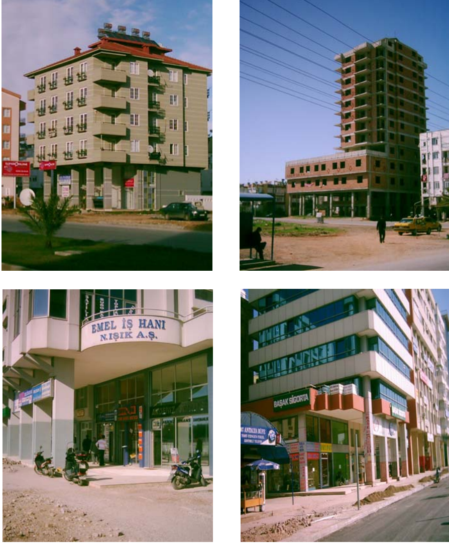
Şekil 1. Antalya’daki düzensiz betonarme binalardan örnekler
