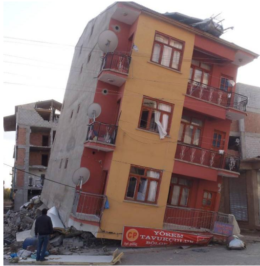
Şekil 19: Erciş, Merkez, zemin katı tamamen göçmüş betonarme bina
