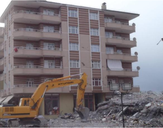
Şekil 25: Erciş, Merkez, Depremi az hasarla atlatan ve toptan göçmüş iki betonarme bina yan yana.
