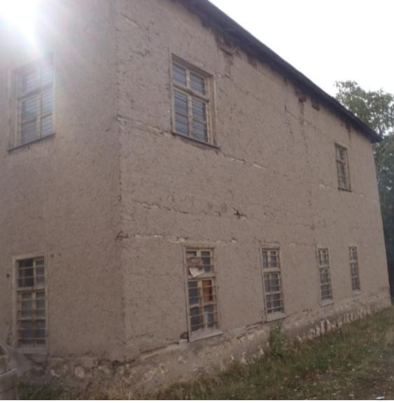
Şekil 24: Erciş, Merkez, deprem kaynaklı hasara sahip olmayan iki katlı kerpiç bina.
