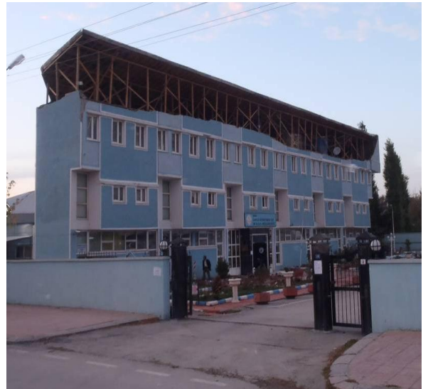
Şekil 22: Van, Merkez, Çerçeve içine alınmamış kalkan duvarın düzlem dışına yıkılması.
