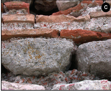
Şekil-3 [C] Duvar örgüde tuğlanın kullanımı ([C] Usage of brick in walls)
