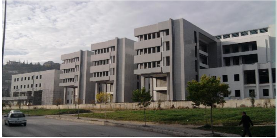
Şekil 4. Morfoloji binası kuzey doğu görünüşü (The north- east view of the morphology building)
