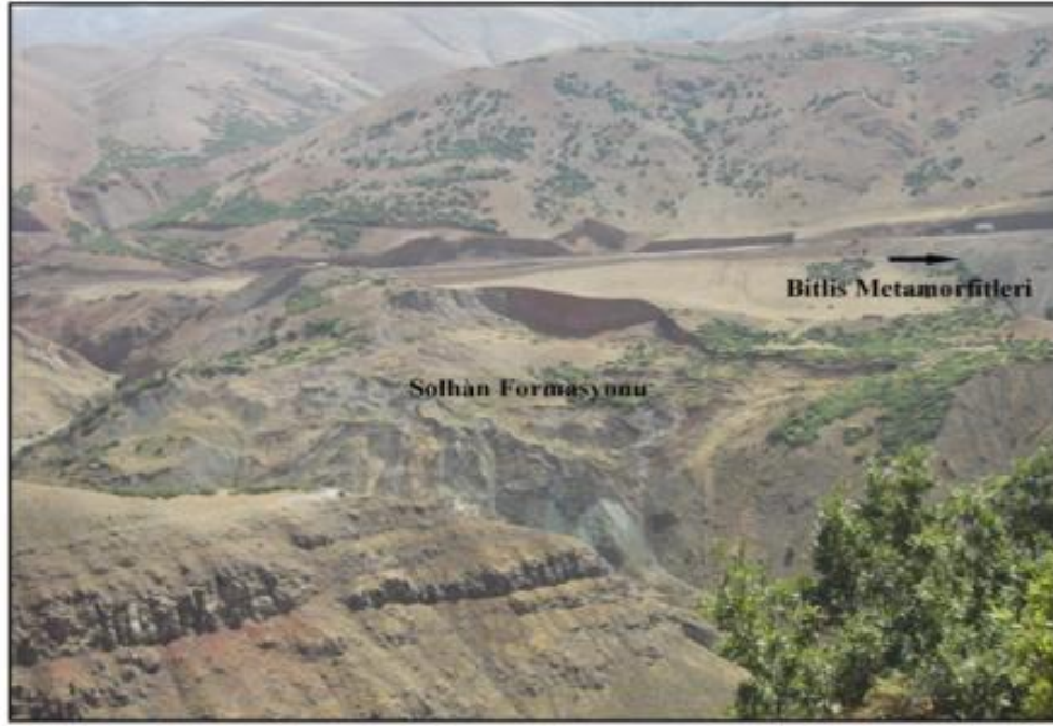
Foto 2. Havzanın güneybatısında tüflü yapıya bağlı olarak heyelanlar görülmektedir.
